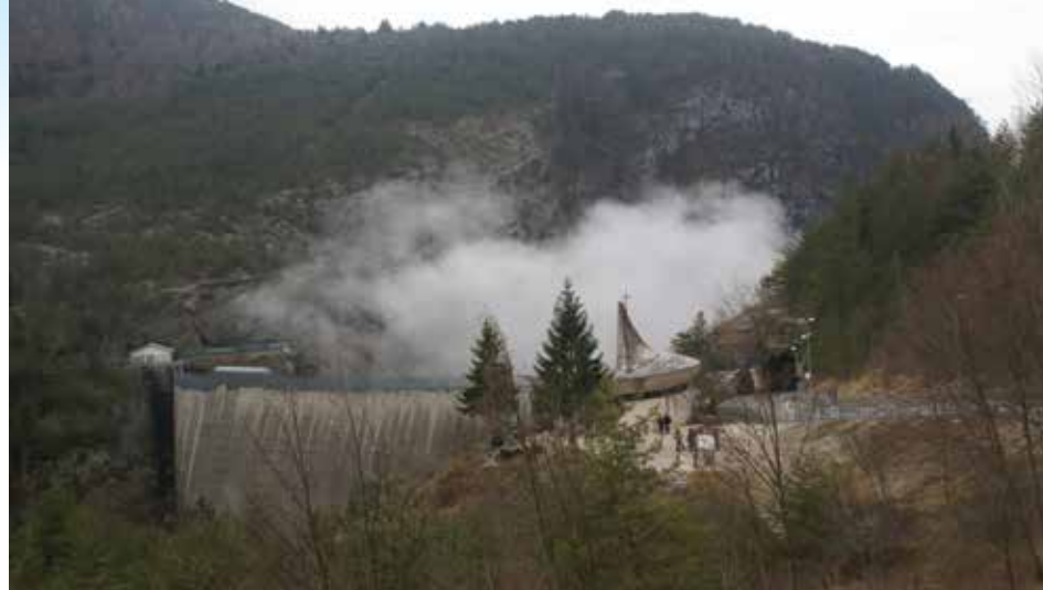
La diga oggi (Ph U.S.)
